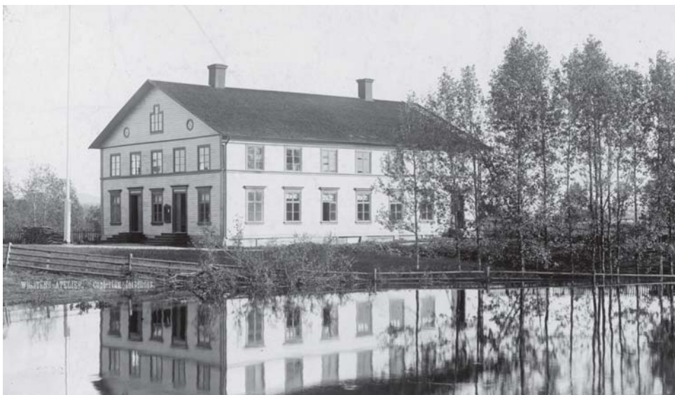
125-årsjubilerande Bollnäs Missionsförsamling byggde missionshuset i Bro under åren 1880 - 1881. Vid invigningen talade missionsförbundets grundare P P Waldenström.
