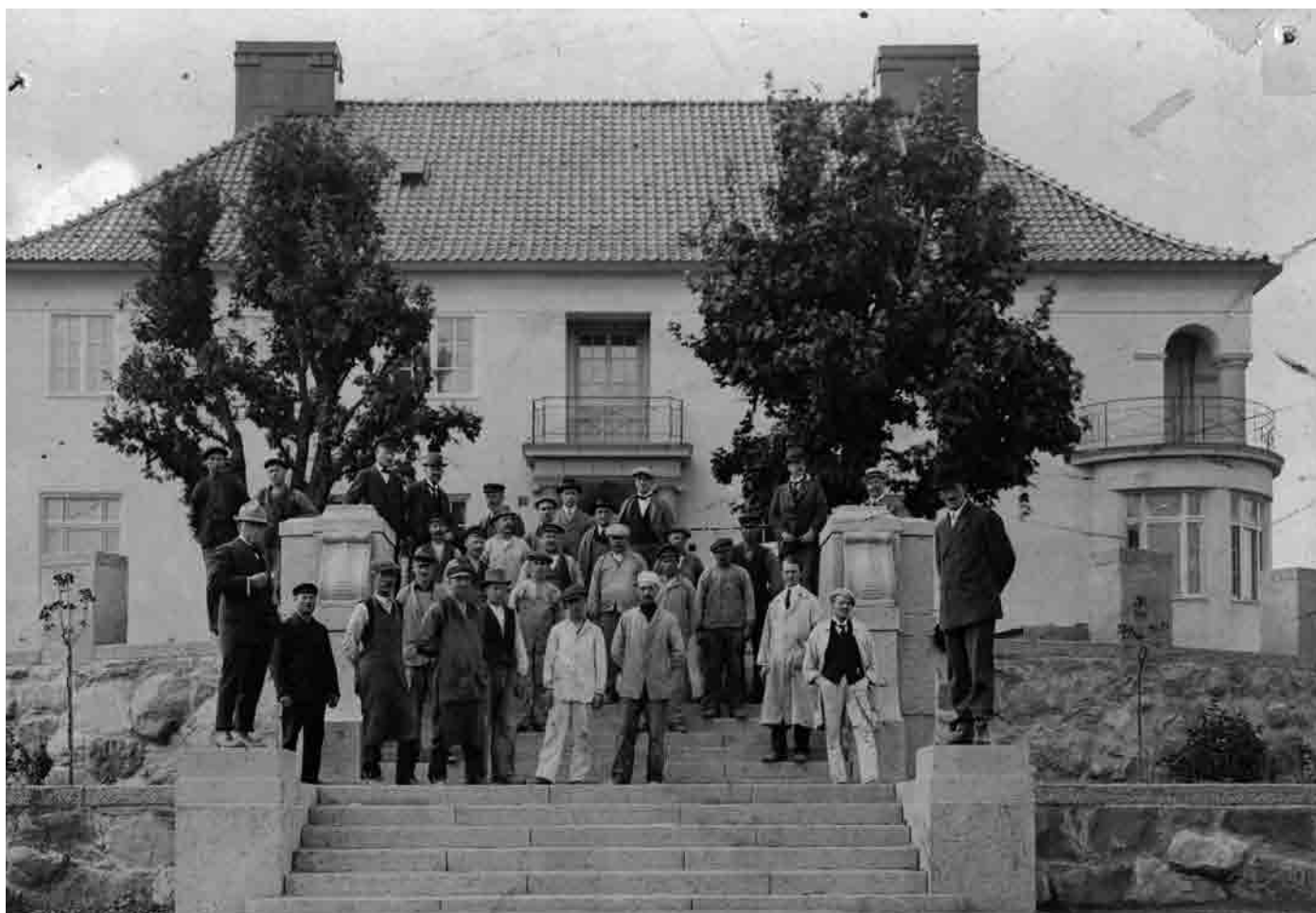
Adolf Ahlgrens villa på höjden ovanför Strömvallen stod färdig 1917. Byggmästare Ansgarius Fahlstedt står längst till höger i bild.
