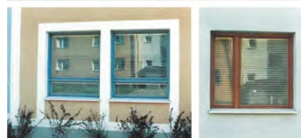
Tallbacken i Söderhamn ses som ett gott exempel på sin tids byggnade.
